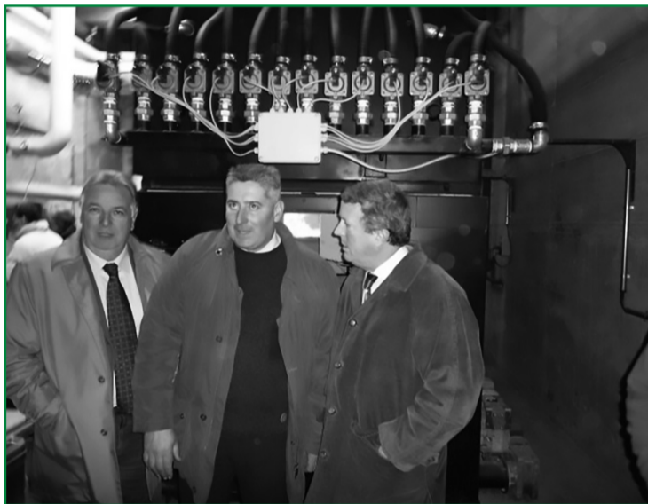
(sullo sfondo la caldaia alimentata a cippato a Marchirolo. Nella foto sx l'assessore Specchiarelli, Livio Bozzolo e Pasquale Gervasin)
